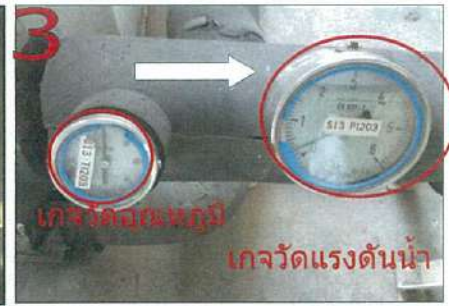
ท่อน้ำเข้า Heat Exchanger ED
